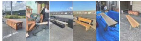
第1回新設ベンチ施工・既存ベンチ修繕 ワークショップイベント開催
